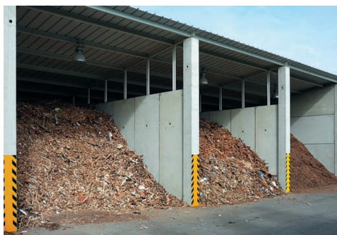
Materiál je uskladněn v boxech pod přístřeškem
