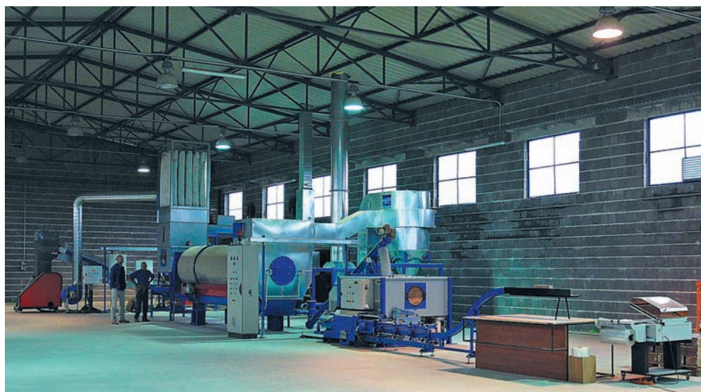
Technologická linka BRISUR na zpracování pilin briketováním
